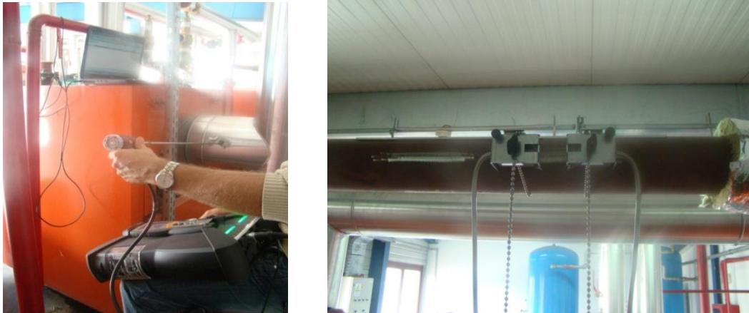
Fig. 5.1 Măsurare compoziție gaze de ardere și debit masic apă caldă
